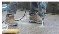
コンクリート面に22mm径程度の穴を深さ80mmまで掘ります。（穴の中の削りかすをキレイに取り除いて下さい。）
