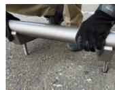
ボルトが穴底に到達した際、接地面と本体に隙間がないかを確認します。
